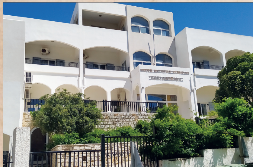
Το κτήριο του Γηροκομείου Κυθέρων, όπως είναι σήμερα
